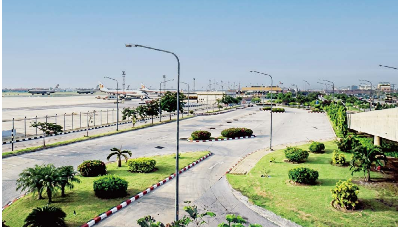
タイ空港公団 バンコク国際空港滑走路拡張工事
