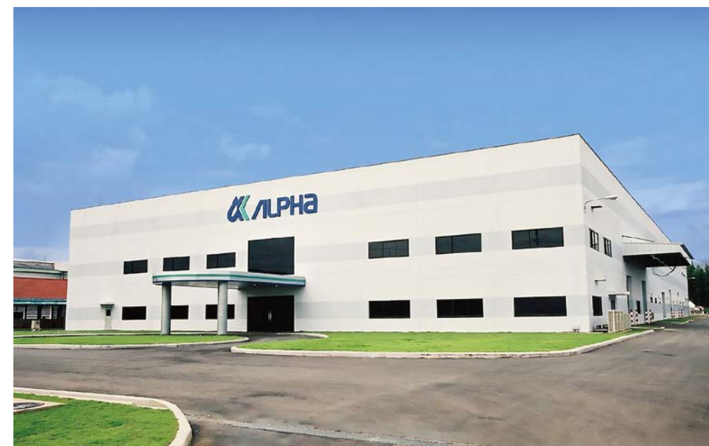
アルファ アルファタイランド工場第5期
