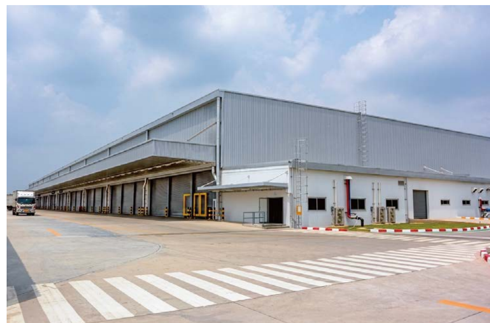
三五 YS PUND Banpho 工場新築工事
