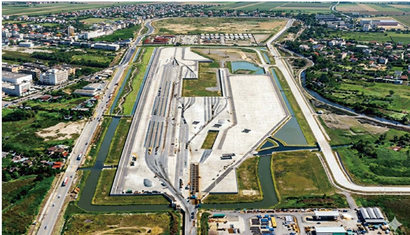
SNMC JV バンコク地下鉄操車場建設工事
