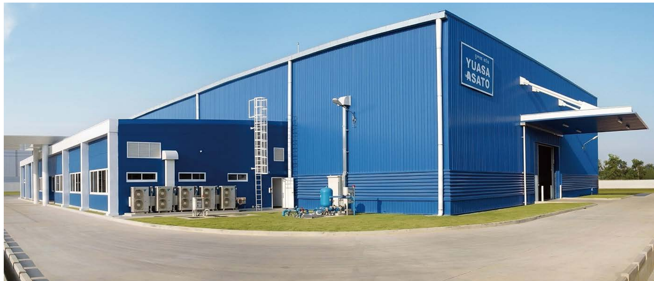
ユアサ工機 サトウ商事合併 ユアササトウ工場新築工事
