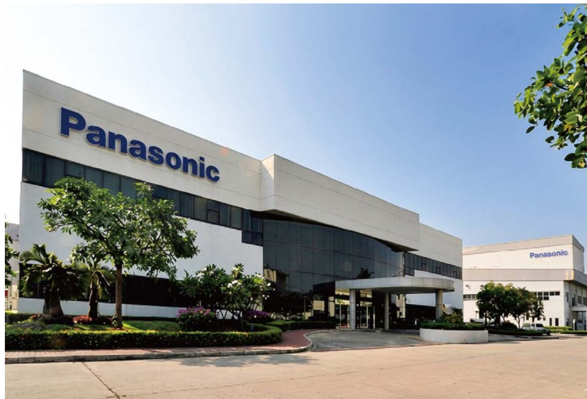
パナソニック(旧 松下電工) アユタヤ工場第1期～第5期 施工場所：ロジャナ アユタヤ県 工事規模：工場 工 期：1994年4月 ▶ 1997年10月 延床面積：48,582㎡ PANASONIC MANUFACTURING AYUTHAYA CO., LTD. AYUTHAYA FACTORY (PHASE1-5) WORKING PLACE : ROJANA I.P., AYUTTHAYA DESCRIPTION OF PROJECT : FACTORY PERIOD : APR 1994 - OCT 1997 TOTAL FLOOR AREA : 48,582㎡
